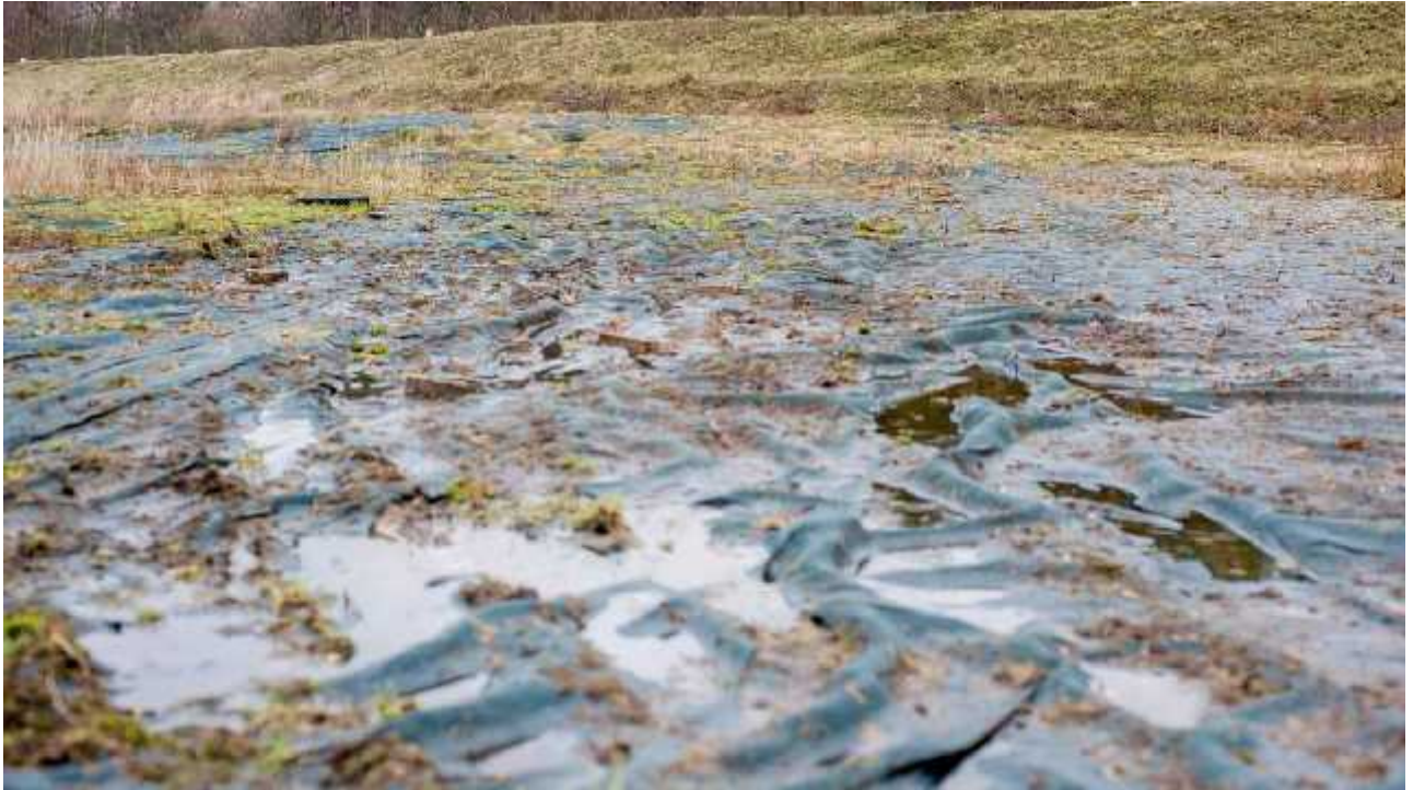
Bodenschutznetze vor dem Sanierungswall von 2007 am Schießstand Waakhausen.
